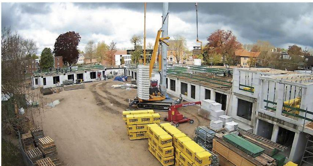
De bouw van de nieuwe Antoniushove. Foto: PR Careaz
